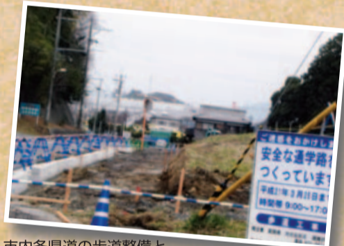
市内各県道の歩道整備と バリアフリー化を推進(葉山・六地藏団地前他)
