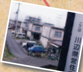
川辺県営住宅第3期建替工事 21年度(5階建40戸)要望決定(治田東)
