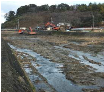
金勝川・中村の県浚渫工事中
