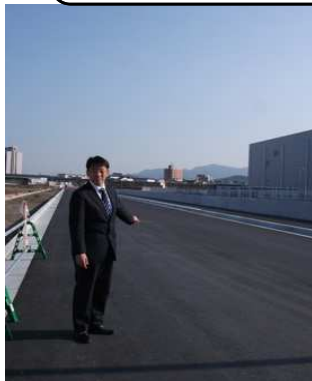
新駅跡地周辺道路整備中
