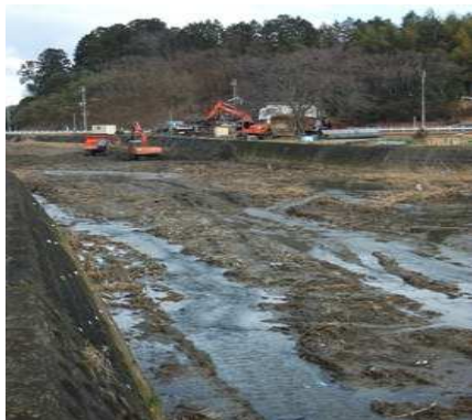
金勝川・中村の県浚渫工事中
