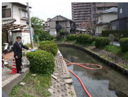
中の井川浚渫工事始まる (4/18～4/25)緒七里地先
