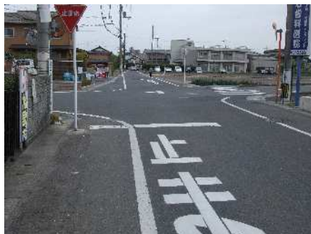
危険箇所・中沢団地 交差点の表示を改良する (4月中旬)
