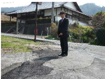
栗東信楽線成谷付近の下水道 工事始まる(3月～) 荒張地先
