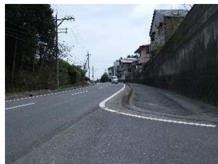
県道上砥山上鈎線中浮気団地 付近の道路を補修(5月～) 上砥山地先
