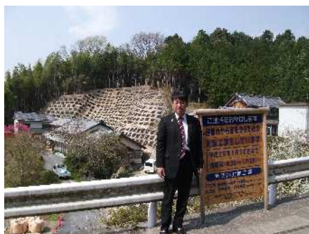
荒張成谷地区の傾斜地 崖崩れ防止工事進捗中 荒張地先
