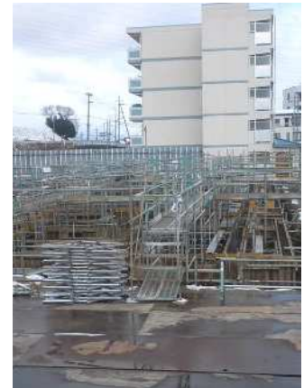
川辺県営住宅4期基礎工事1年前倒しで進む(2/9)
