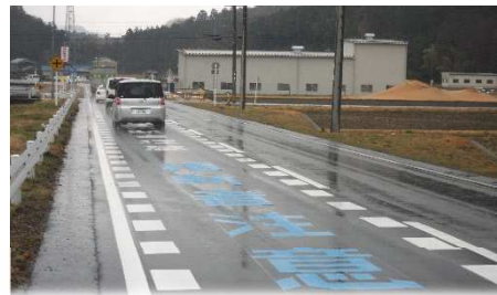
県道 石部・草津線(御園八王子交差点) 改良へ (3/5)
