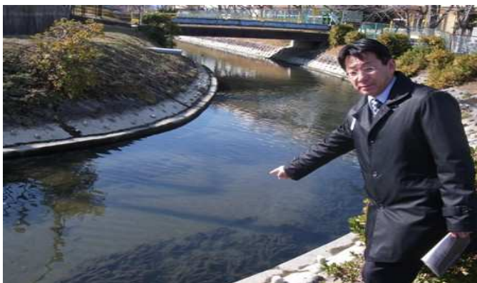
糞・中ノ井川の土砂汚泥の現況視察。対策を県へ求める
