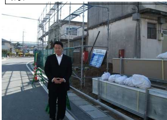
県営川辺住宅・来年度の第4期工事に向け解体工事進む
