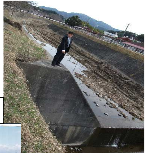
市内の河川整備(金勝川浚渫)県道(川辺御園線迂回路)の道路整備の進捗状況を把握するため現地視察
