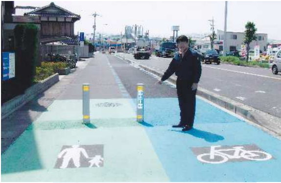
栗東市内県道の通園通学路の歩道自転車自動車道の分離とバリアフリー化を進める
