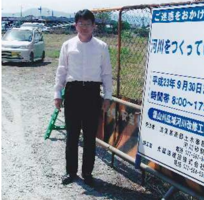
国道1号線(坊袋地先)交差部工事により葉山川の河川拡幅工事はじまる
