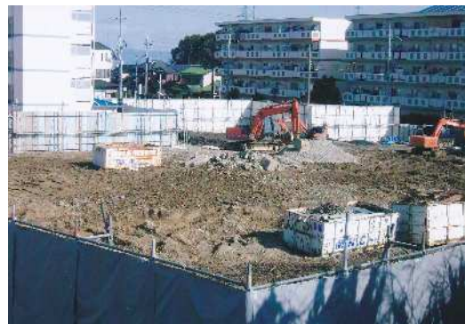
老朽化した川辺県営住宅の新築工事はじまる
