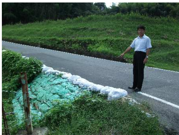
県道栗東信楽線成谷地先の道路陥没箇所を補修
