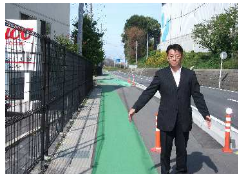
六地藏三菱重工前の県道の 歩道整備を進める(10/26)
