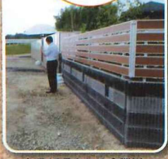
台風18号からの金勝川復旧工事進む(目川)
