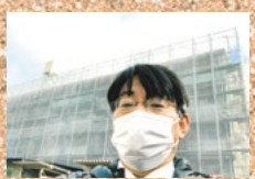
小井井県営 住宅工事進む
